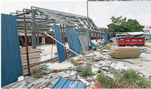
巴剎工地其中一面圍牆已被破壞，不僅圍牆鐵片散落地上，還有許多垃圾及破爛沙袋丟在地上。
